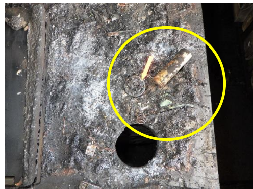
写真8 携帯型扇風機の焼損状況
