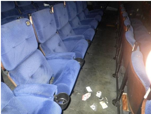
写真5 シアター内の焼損状況
