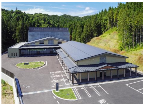
▲塩釜地区りふ斎苑(火葬場)
