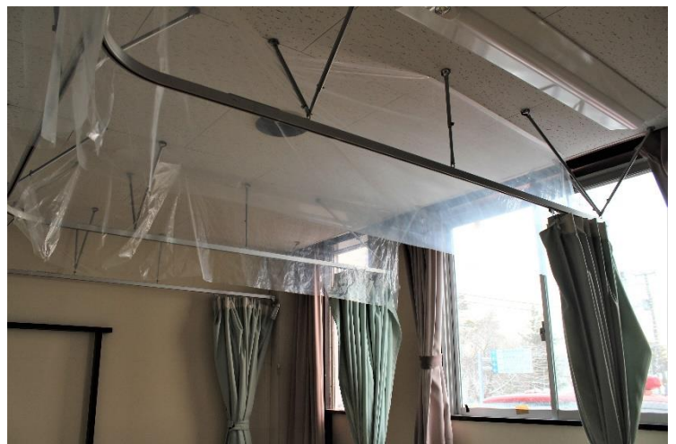
仮眠室の仕切りカーテン上部に張られたビニールシート
