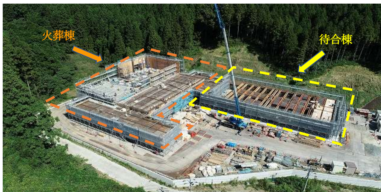
工事現場の様子（令和2年9月30日撮影）
