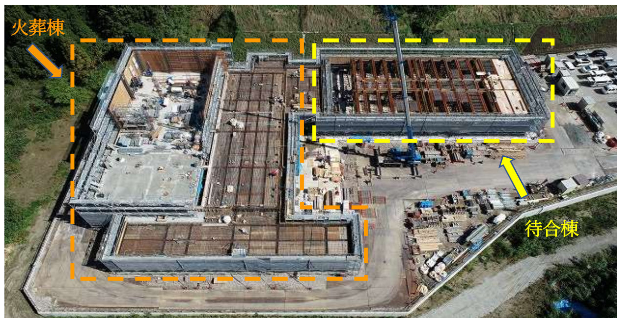
工事現場の様子（令和2年9月30日撮影）
