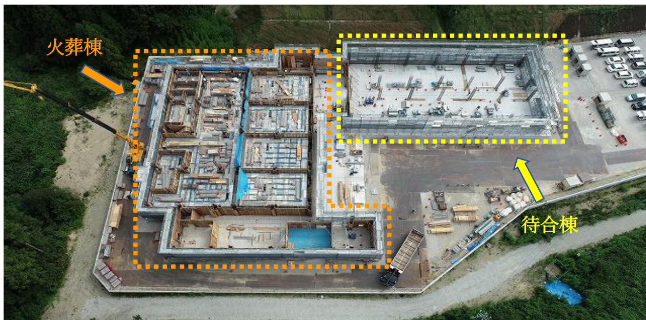
工事現場の様子（令和2年8月27日撮影）
