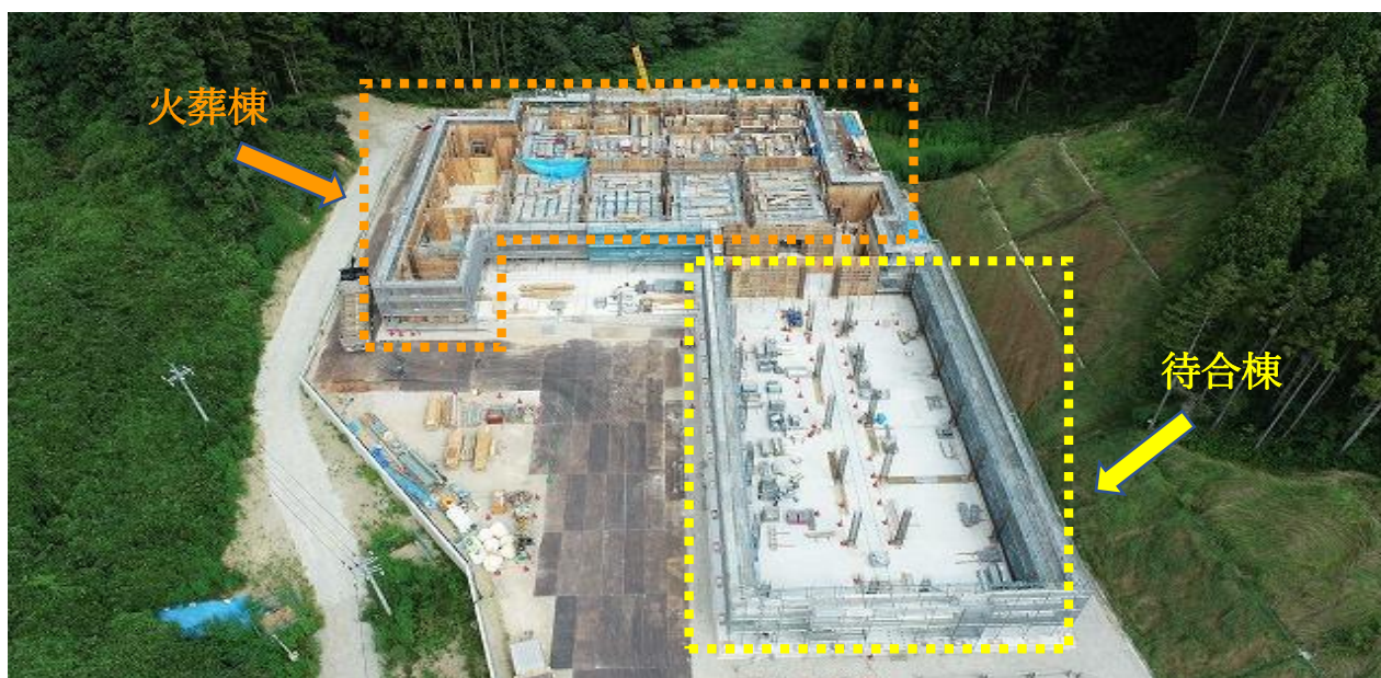
工事現場の様子（令和2年8月27日撮影）
