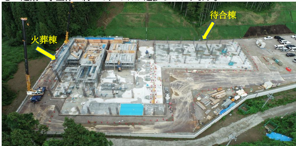
工事現場の様子（令和2年7月22日撮影）
