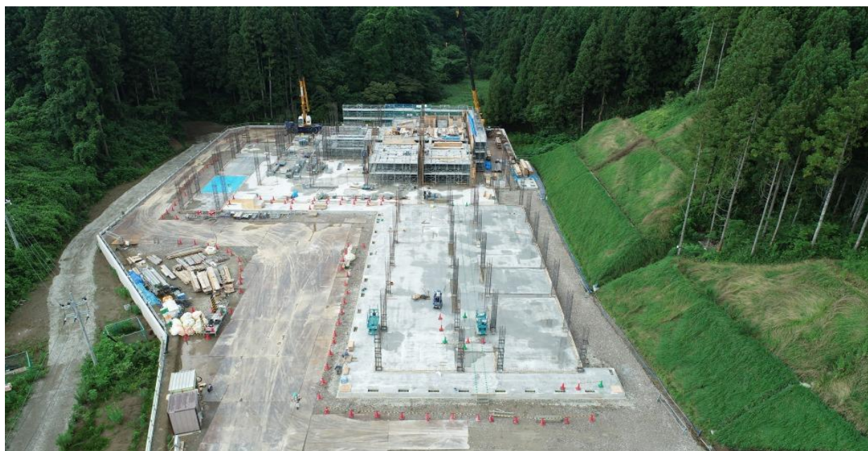
工事現場の様子（令和2年7月22日撮影）
