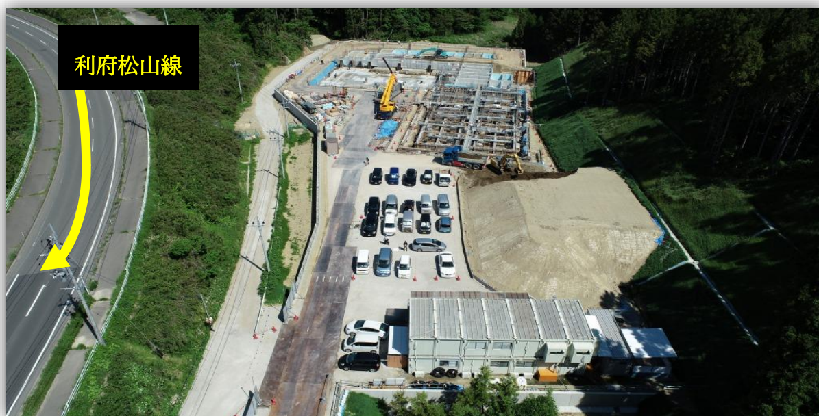
工事現場の全景（令和2年5月末撮影）
