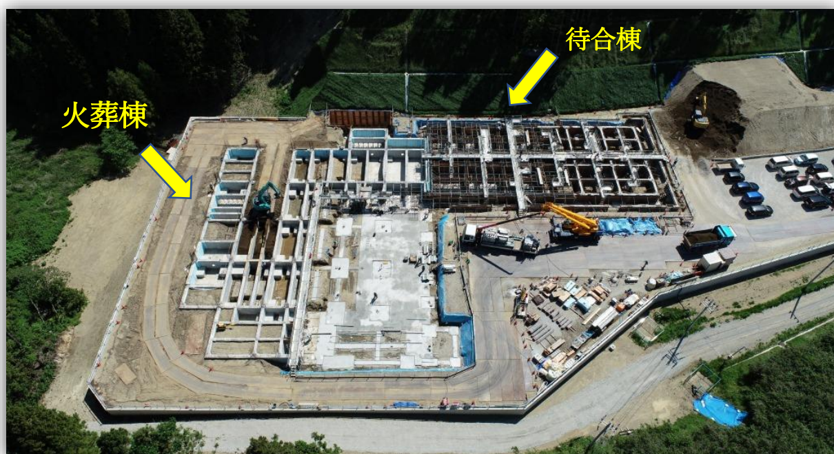
躯体工事の様子（令和2年5月末撮影）
