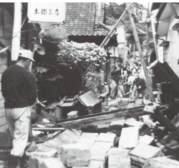
住宅街のブロック塀が倒壊
