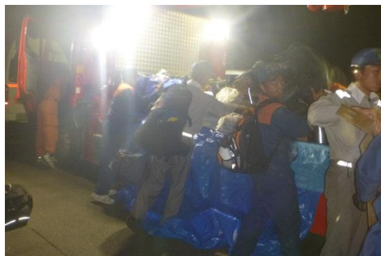
次の災害に備え資機材等の積替え
